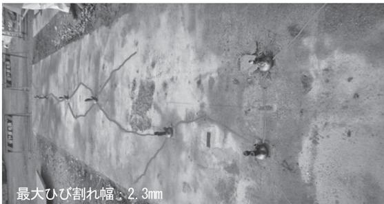
写真一4 地中梁破壊状況
