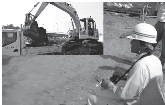
写真—3 土砂積み込み作業状況
