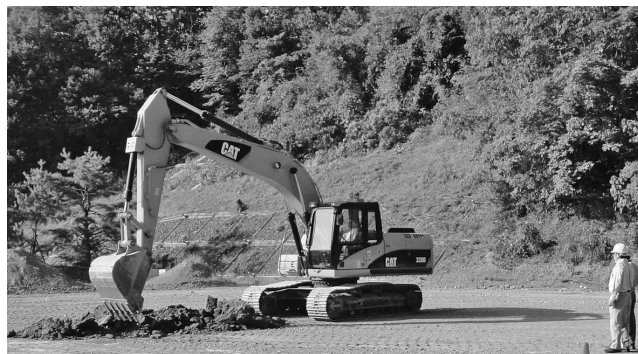
写真—4 リモコン仕様の建機
