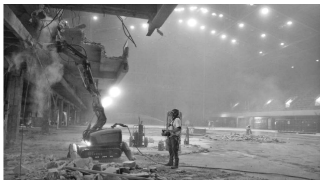
写真—5 コンサートホール2階部分の改修工事
