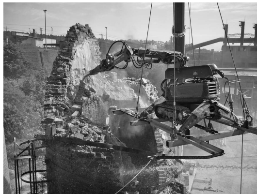
写真—6 煙突解体時の写真
