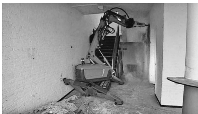
写真—3 屋内現場施工例
