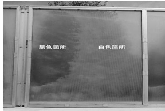
写真一 透光板の劣化状況
