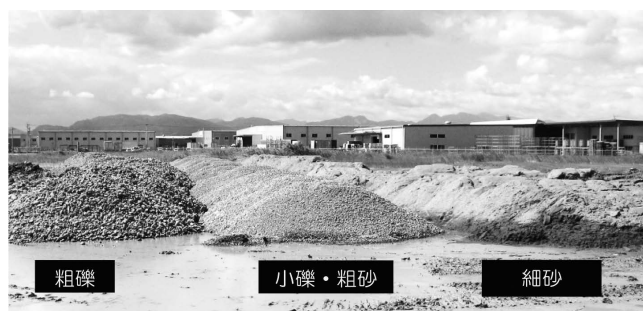
写真—7 分級処理後の砂礫の仮置き状況
