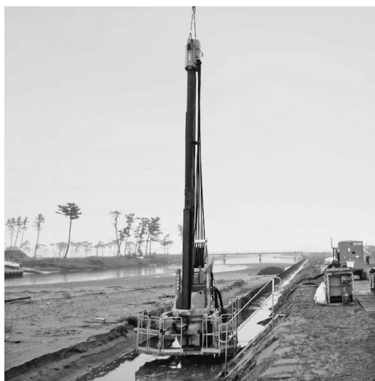
写真—3 施工状況
