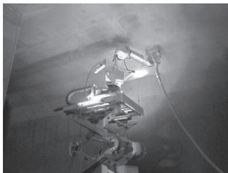
写真—4 施工状況（研掃）
