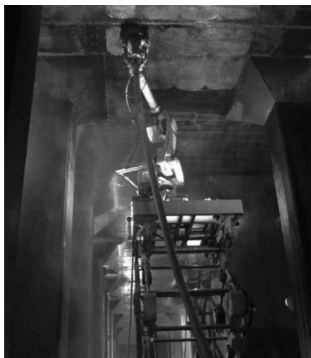
写真—5 施工状況（塗膜除去）
