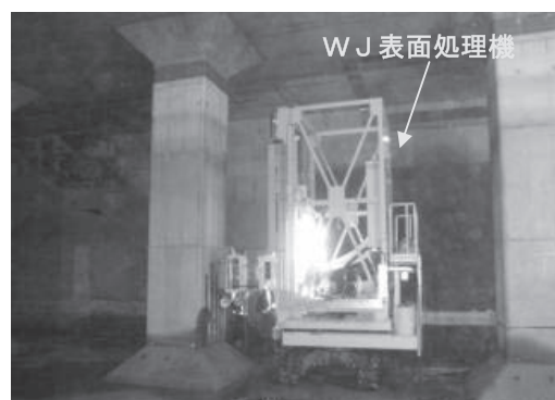
写真—6 壁・柱用 WJ 表面処理機の施工状況
