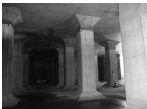
写真—3 上水道給水所の配水池
