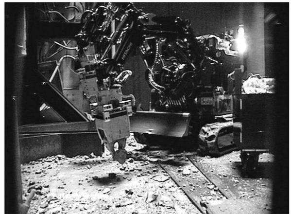
写真-10 建屋内での瓦礫撤去
