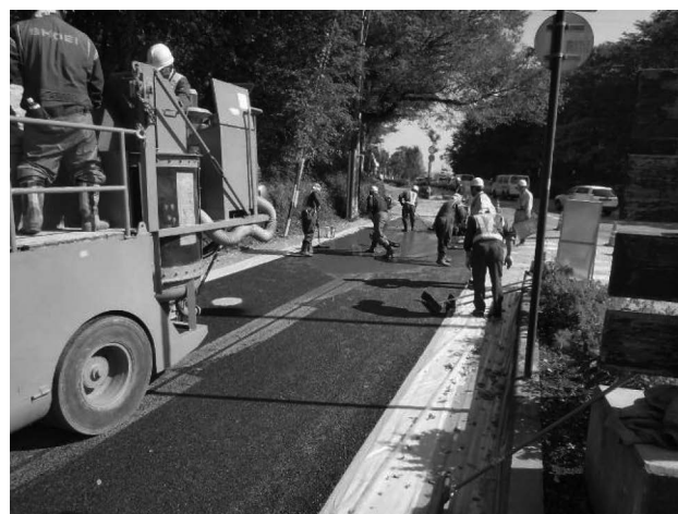
写真—11 一般道半たわみ舗装工事（昼間）
