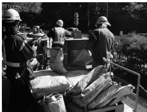
写真—12 ミキサへの投入作業
