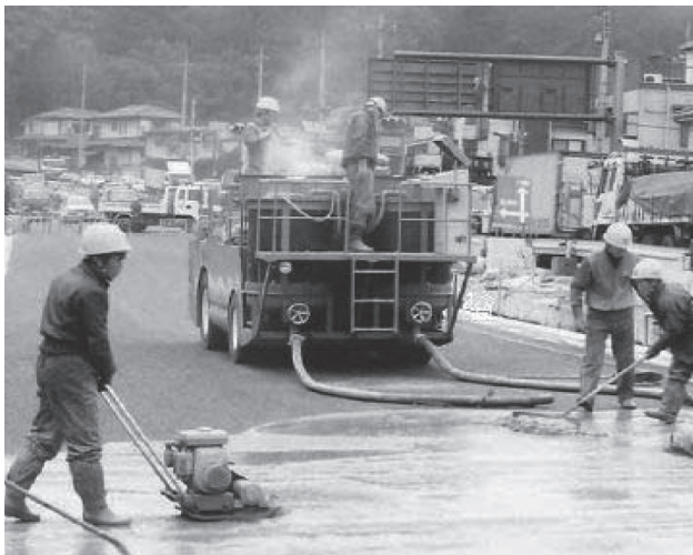
写真一 2 従来の施工作業全景
