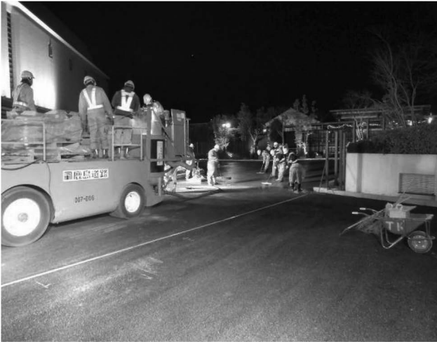
写真—13 ホテルエントランス外構改修工事（夜間）
