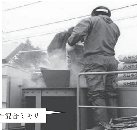
写真—5 従来のセメント投入作業
