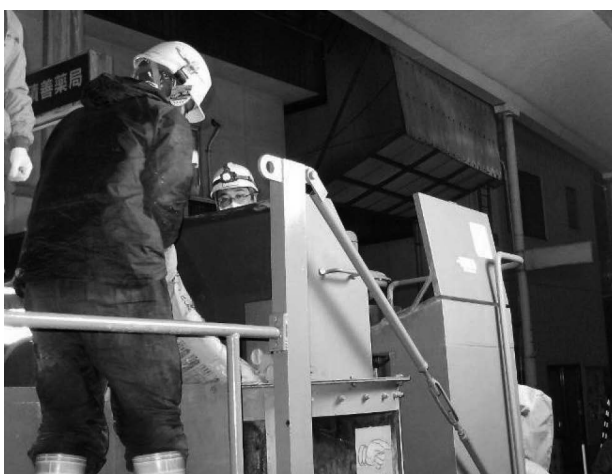
写真—9 ミキサへの投入作業
