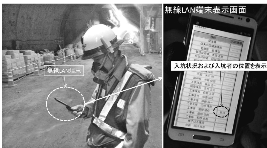
図-7 無線 LAN 端末使用状況と入坑者位置表示画面の例
