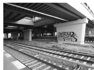
写真—7 無残な新設の橋脚
