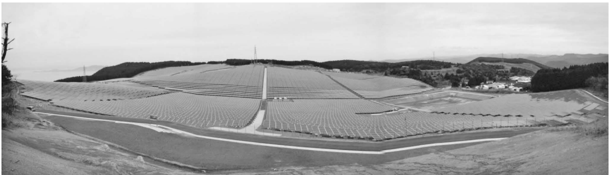
写真一 2 施工終了時（敷地南側から撮影）
