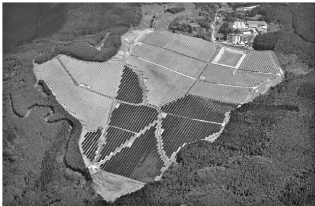
写真-1 発電所全景
