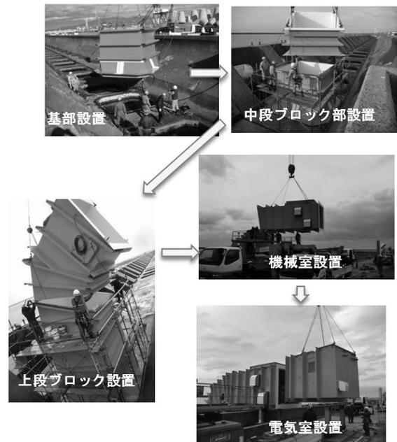
写真一2 発電装置設置状況（H26年12月）
