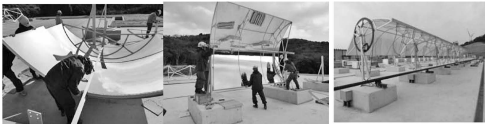
写真-1 小型集熱装置の組立
