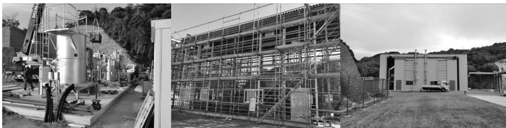
写真—4 ボイラー据付、建屋建設
