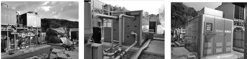
写真—3 バイナリー発電装置の据付
