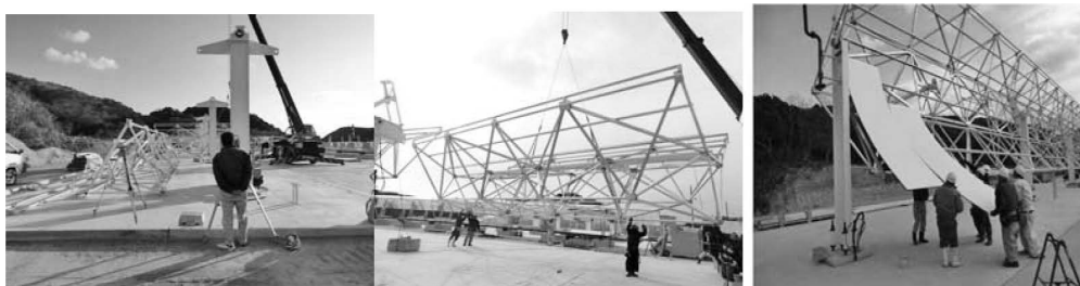
写真-2 大型集熱装置の組立
