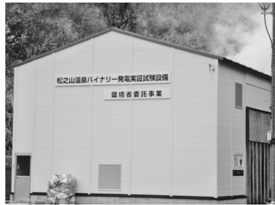
写真—1 松之山温泉バイナリー発電実証実験設備
