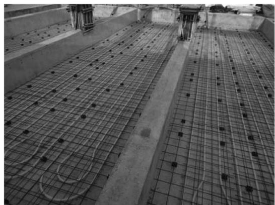
写真-4 床打込み配管敷設状況
