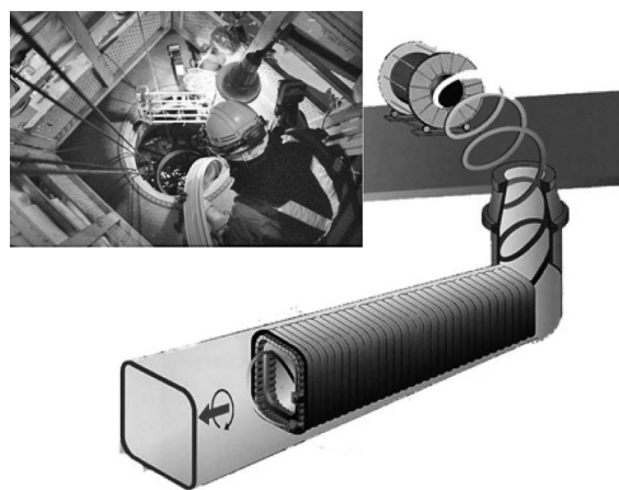
図—5 製管工法の一例
