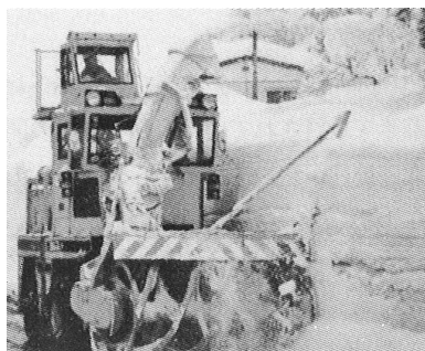
写真 2-117 高所運転室付ロータリ除雪車 (株新潟鐵工所 (注3) (北陸地方建設局と共同開発) 昭和 59 年)
