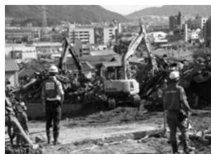
地元建設業と連携した土砂撤去
