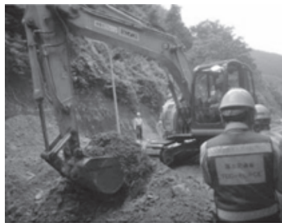
地元建設業と連携した孤立集落解消に向けた土砂撤去
