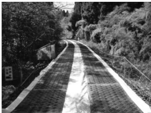
写真—6 上部進入路（既設軌道補強）
