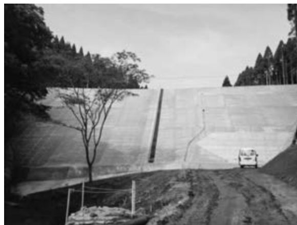
写真—7 完成写真
