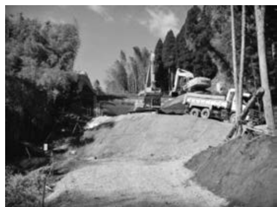
写真－5 盛土下層部の施工状況
