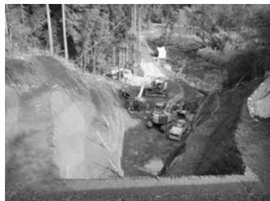
写真－4 最下層部の施工状況
