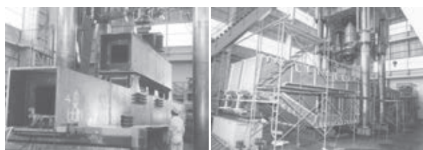
明石海峡大橋 補剛トラス部材 (HT780)
