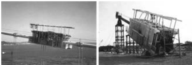
図—2 吊橋ケーブル補修用作業車 (ケレン作業車, ラッピング作業車) 施工性能調査 (本州四国連絡橋公団 平成 5 年度)
