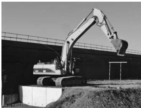
写真—4 エネルギー消費量確認試験の状況
