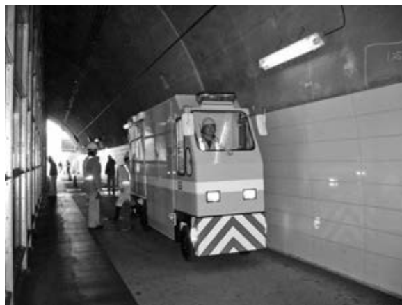
写真—1 トンネル壁面清掃車の実証試験の状況
