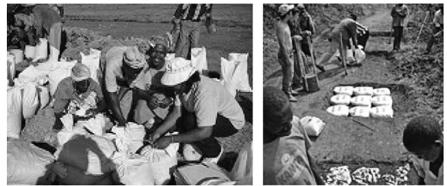
写真-1 住民が土嚢を用い道路を整備 短期間に施工可、雇用創出にも貢献 (出典: JICA ホームページ)
