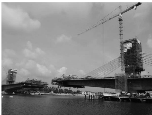
写真—7 M2-M3 径間 片持架設施工の様子
