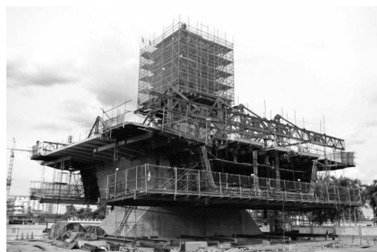
写真—6 M3 移動作業車組立状況
