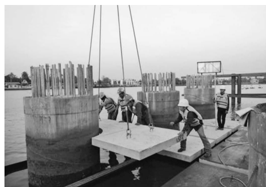
写真ー3 フーチング底板部プレキャストパネルの設置
