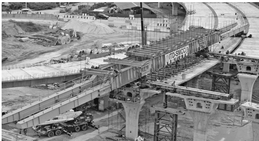
写真—12 スパンバイスパン架設工法によるインターチェンジの施工状況
