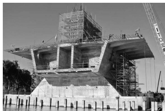
写真—5 M3 柱頭部施工完了
