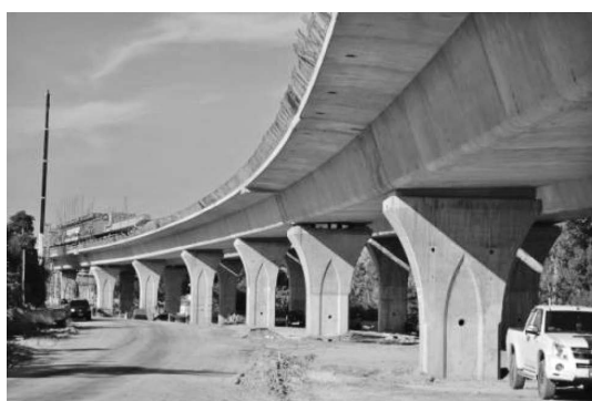
写真—13 スパンバイスパン架設で施工されたアプローチ橋
