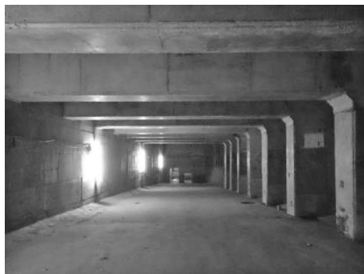
写真—11 桁内部の状況
