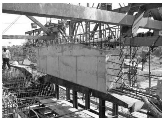
写真—10 プレキャストリブの設置
