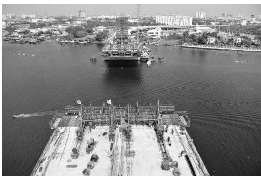
写真—8 M3 主塔上から橋面を望む
