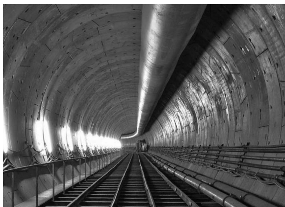
写真－4 施工中のシールドトンネル内部
