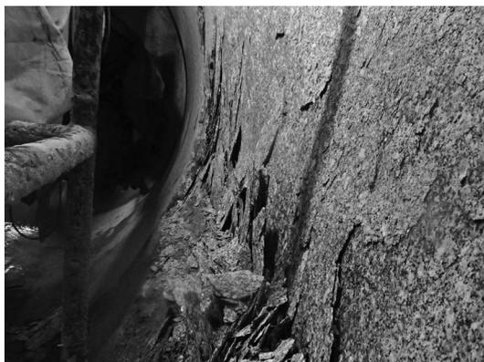
写真一七 TBM-1 山はね発生状況 (左側壁部)
