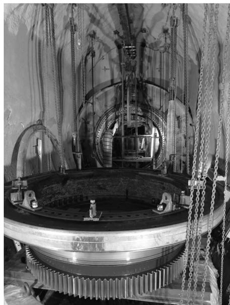
写真一九 TBM-2 メインベアリング交換状況
