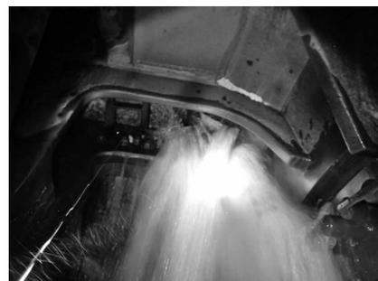
写真一 2 TBM-1 突発湧水状況 (TBM カッタヘッド部)
