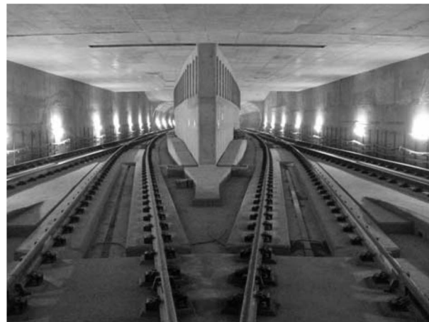
写真—5 クロスオーバー部の構造
