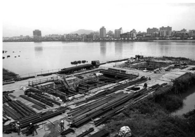
写真一八 淡水河埋立てと分岐立坑
