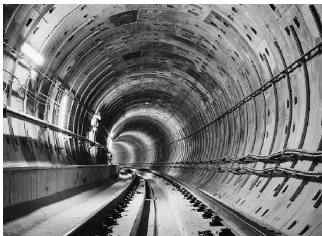
写真—1 下り線シールドトンネル坑内
