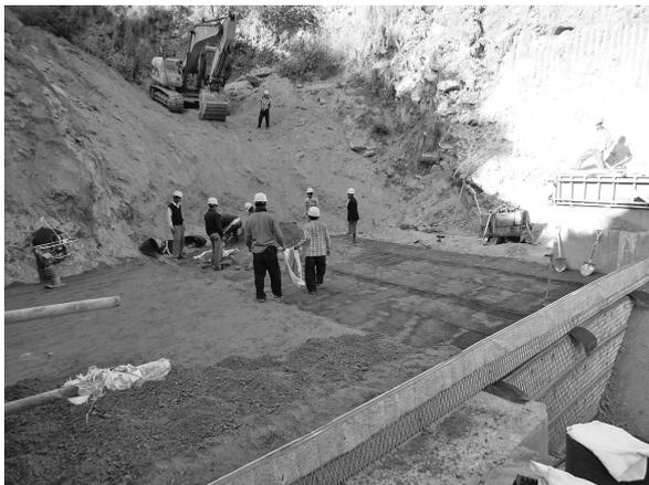
写真—2 補強盛土壁工事写真
