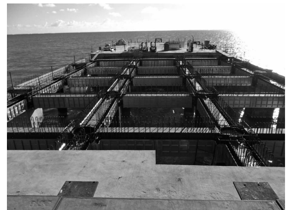
写真一八 梁部固め完了
