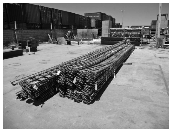
写真—2 加工済鉄筋
