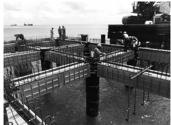
写真一七 梁鉄筋組立状況
