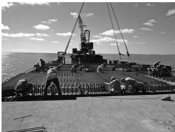
写真—9 スラブ据付状況
