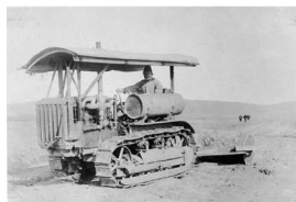
写真-18 ロータリ・スクレーパ牽引
