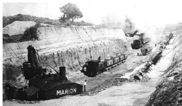
写真—1 嘉南大圳の灌漑用水路掘削
