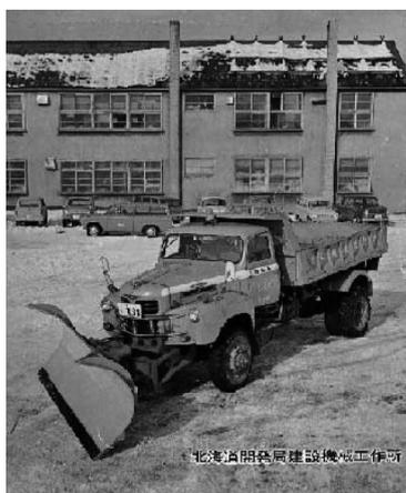
写真 3-37 切削角可変形アングリングプラウ 北海道開発局 昭和 42 年<sup>5)</sup>
