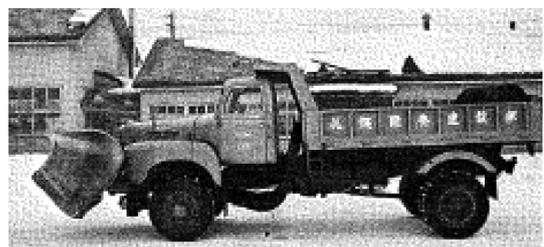
写真3-34 建機形プラウ特殊懸架装置 北海道開発局 昭和39年<sup>1)</sup>
