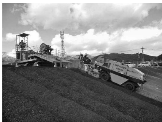
写真—2 切削機作業現場写真
