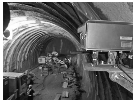
写真一 4 切羽ウォッチャーの据え付け状況
