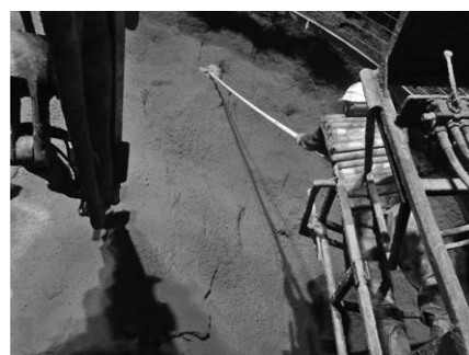
写真一 5 再帰性反射塗料の切羽への塗布状況
