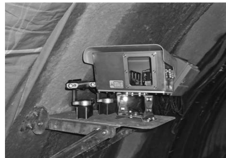
写真一 3 3 方向レーザ変位計
