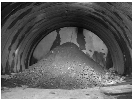
写真一 1 追加押さえ盛土 (合計約 130m 3 ) の施工後状況
