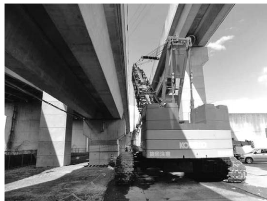
写真—3 営業線に近接工事したクレーン作業
