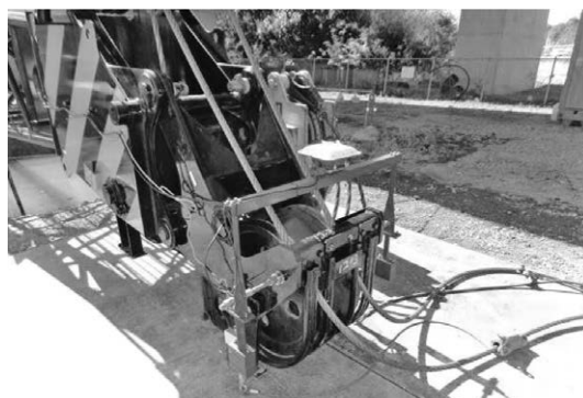
写真—2 クローラークレーンへのGNSSアンテナ設置
