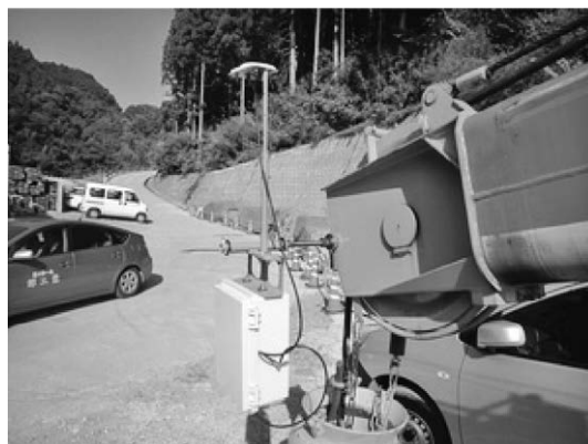
写真—1 トラッククレーンへの機器設置
