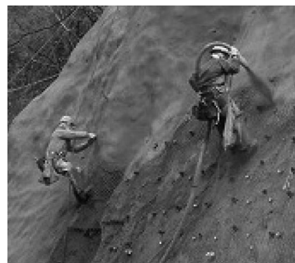
写真一 二 通常施工
