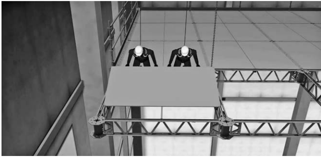
図一7 床材を設置
