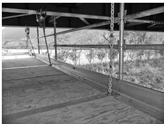
写真一六 専用手摺とL型幅木
