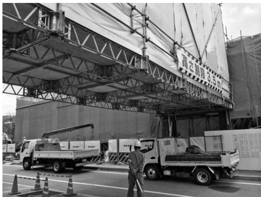
写真一12 連絡通路メンテナンス工事
