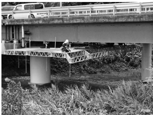
写真一10 橋梁補修工事
