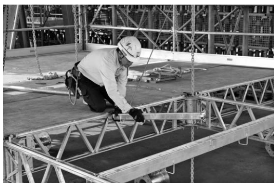
写真一八 サポートビーム取り付けの様子
