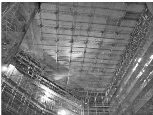
写真一11 ショッピングモール吹き抜け工事
