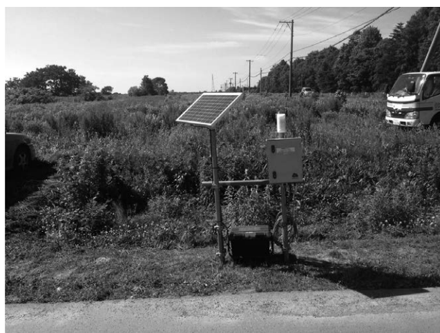
写真一3 電源供給装置
