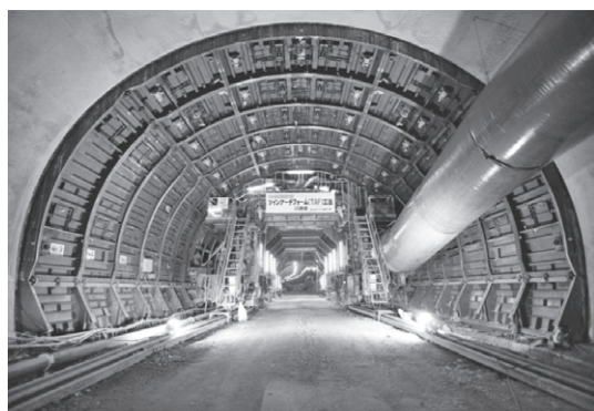
写真—2 施工状況（岩古谷トンネル）
