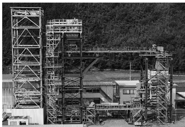
写真-1 スネークベルコン実証実験 (日本コンベヤ姫路工場)
