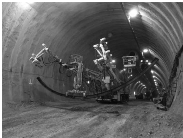
写真-1 インバート支保工の一括化
