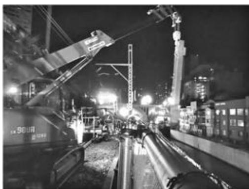
写真一6 縦梁設置状況（線路内より）
