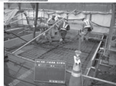
写真一1 アウトリガー支持地盤施工状況 (上：鋼製構台組立，下：RC床版コンクリート打設)
