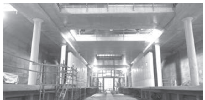
写真—7 本体駅舎躯体（軌道・ホーム階）
