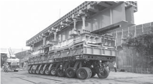
写真—4 撤去桁模擬試験
