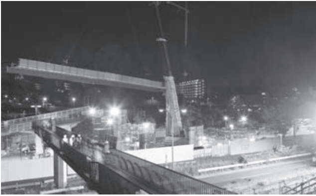
写真一 鋼桁一括架設状況
