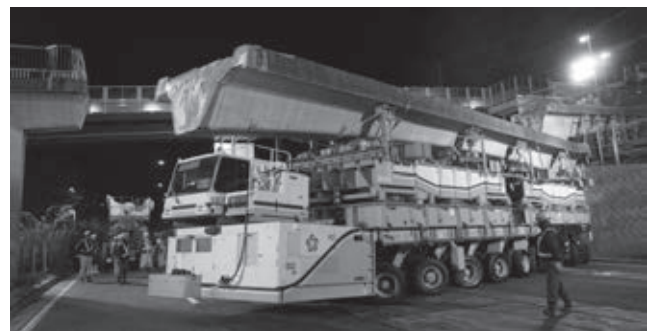
写真—6 桁搬出状況
