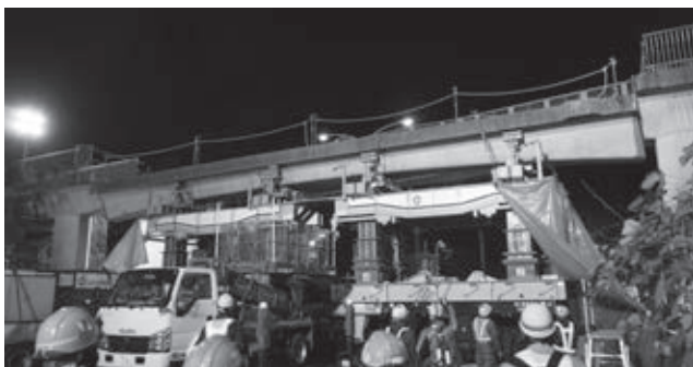
写真—5 ジャッキダウン状況
