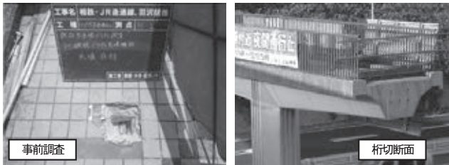
写真—3 PC グラウト充填状況・桁切断面
