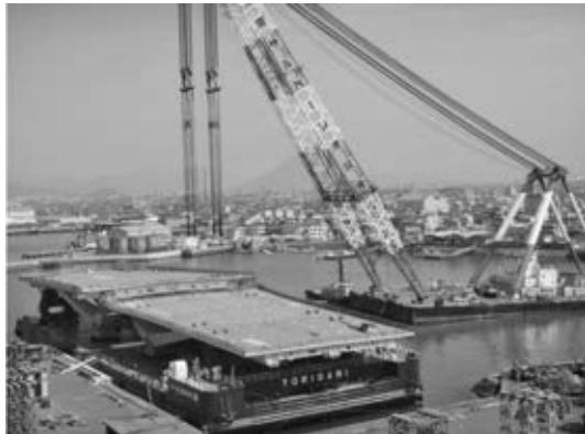
写真-2 側径間大ブロックの台船搭載
