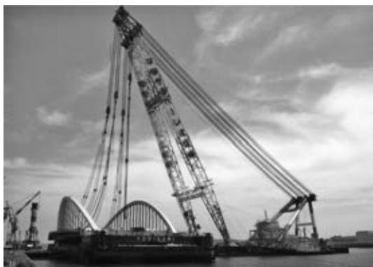
写真一7 中央径間の台船搭載状況
