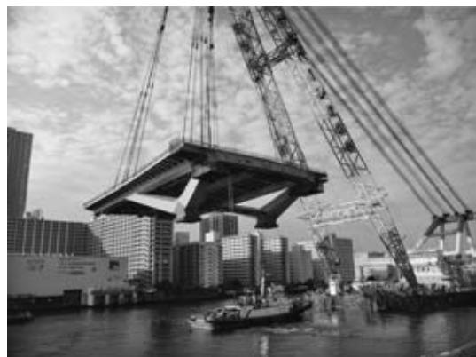
写真-4 勝どき側側径間大ブロック架設状況
