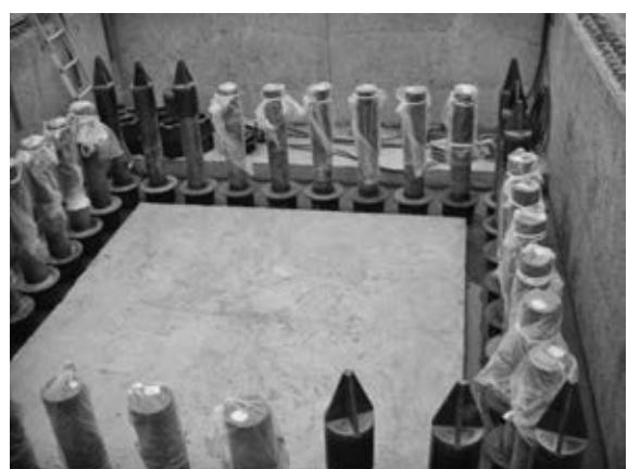
写真-5 鉛筆状アンカーボルトガイド治具
