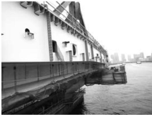
写真一8 側径間側に設置した仮受け台
