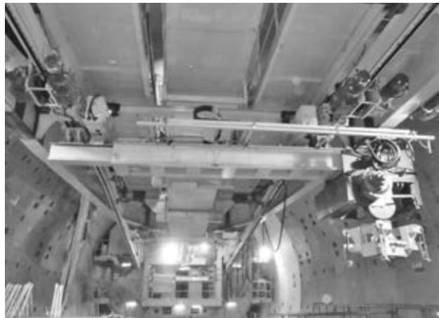
写真一4 後続台車天井クレーン
