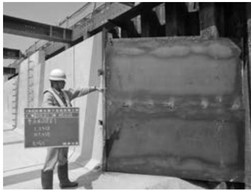
写真一 8 擦り付け整流板
