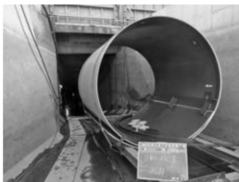
写真一 9 鋼管挿入状況
