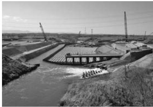
写真一 10 護床ブロック施工状況
