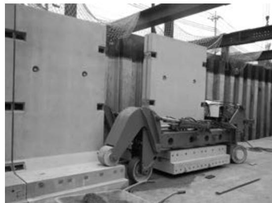
写真一4 プレキャスト擁壁据付状況
