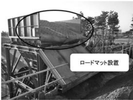
図一10 CSG材2投入ホッパーロードマット設置状況
