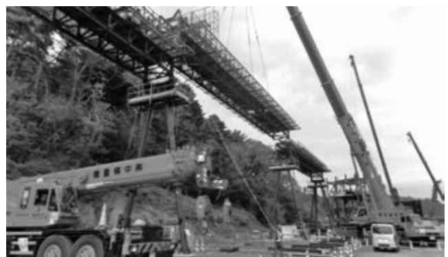
写真-9 ベルトコンベヤ設置状況
