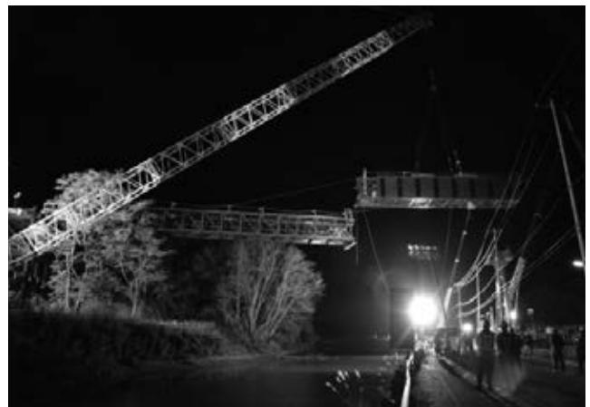
写真-8 750tクレーンによる架設状況
