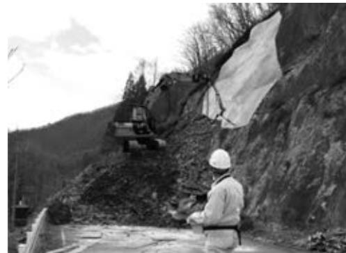
図-2 遠隔操作施工イメージ
