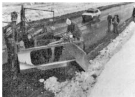
写真3-122 昭和51年製サイドウイング・マックレー装置 北海道開発局 昭和51年 7)
