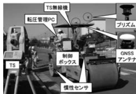
写真一 機器の取り付け状況
